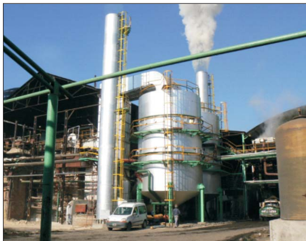
Figura 1. Lavador de gases de combustión operando en una fábrica azucarera tucumana.
